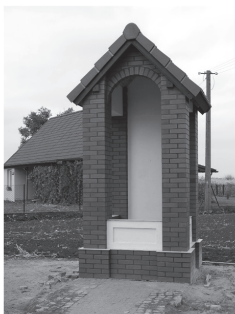
Rys. 5. Kapliczka w Nowym Dworze w trakcie realizacji (fot. autor)
