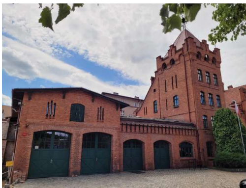
Rys. 7. Toruń. Dawny budynek główny Miejskiej Straży Ogniowej (fot. autor)
